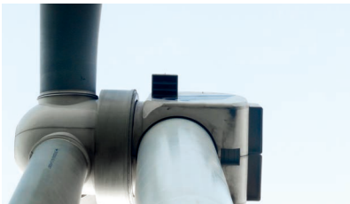
发电机出风口安装消音器
