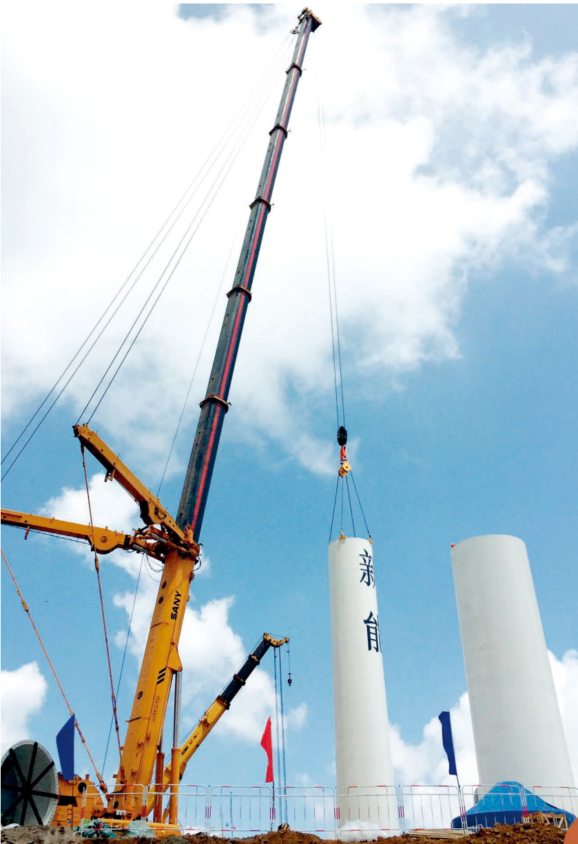
确保吊装作业安全
