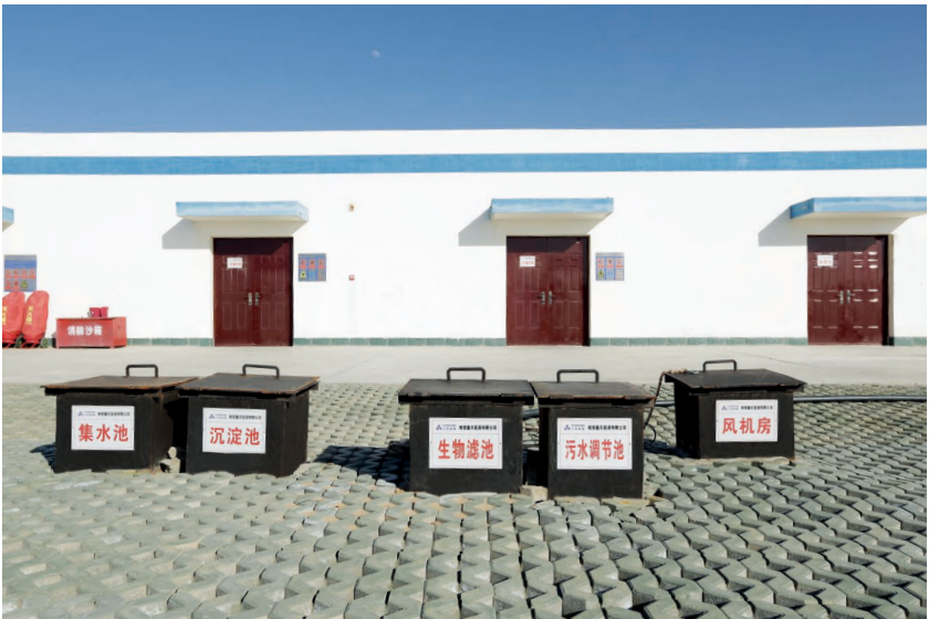
风电场污水处理设施
