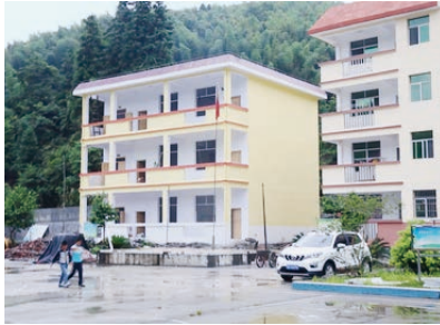
天润捐建的综合教学楼
