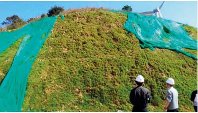
龙归风电场在工程施工中对检修道路开挖断面上边坡采取挂网喷播植草措施，及时对边坡实施复绿。
