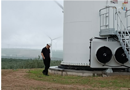
志兴风电场风机塔筒周边植被恢复
